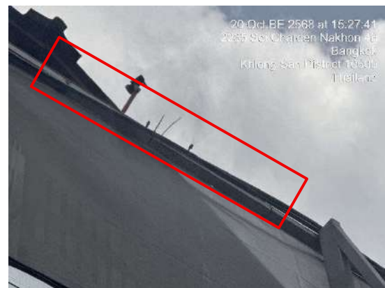
รูปที่ 13 การติดตั้งสเปรย์พ่นน้ำ
