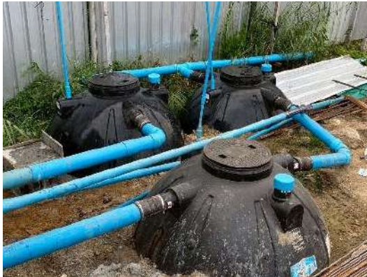
รูปที่ 23 ถังบำบัดน้ำเสียสำเร็จรูปรองรับน้ำเสียจากห้องน้ำ
